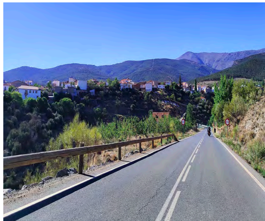
Fig. 20. Carretera de acceso a Albuñan.
