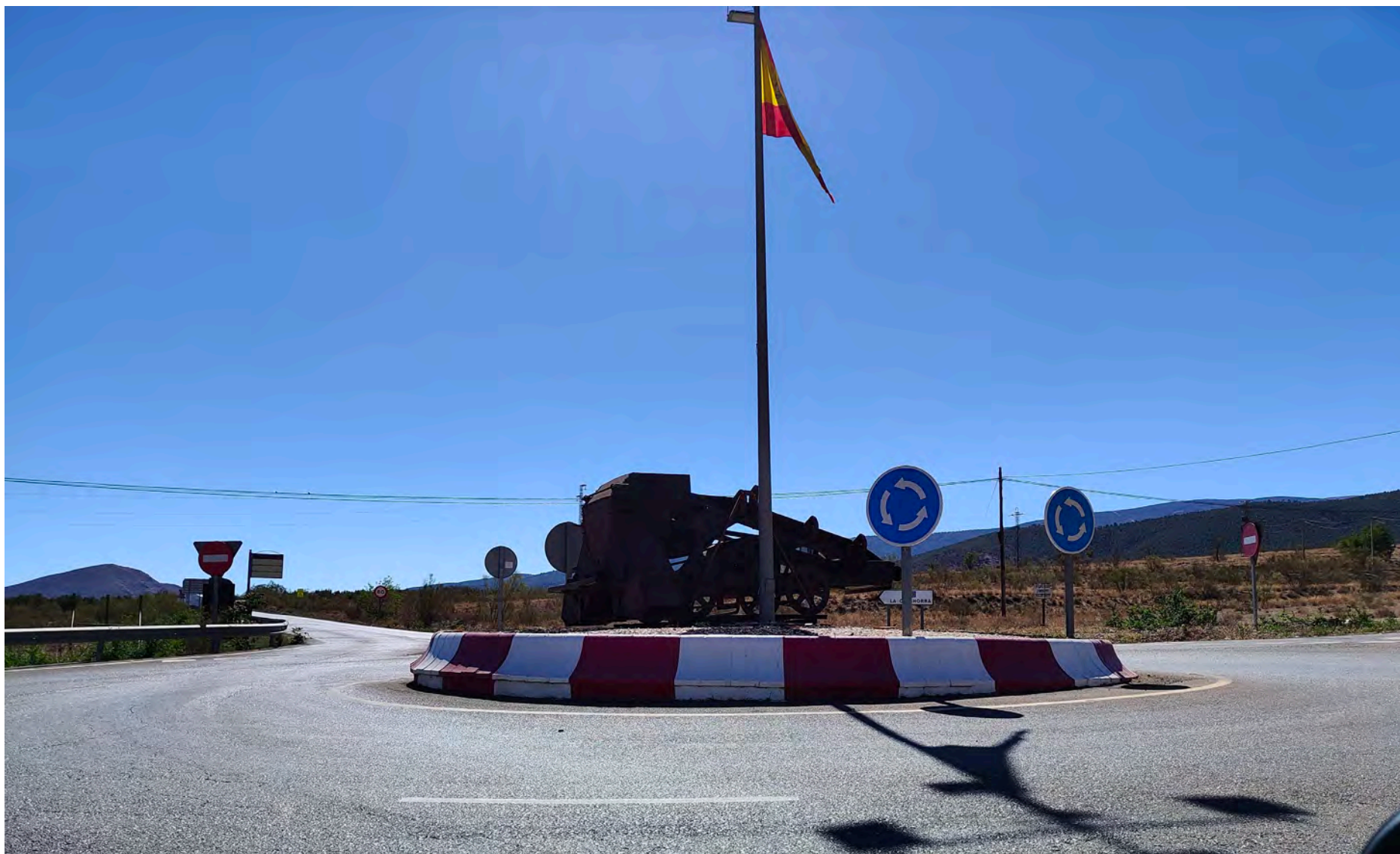
Fig. 41. Rotonda del Marquesado del Zenete. Elaboración propia.
