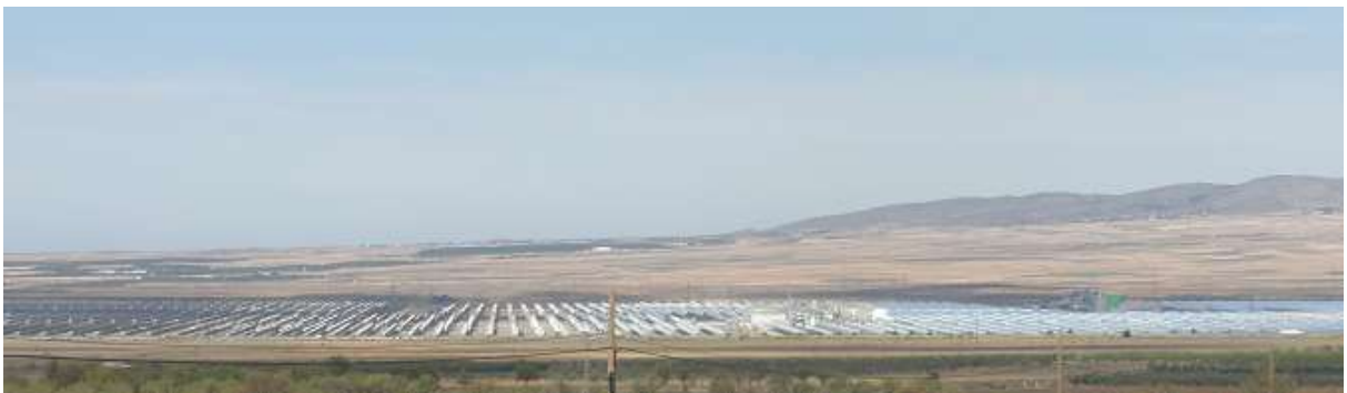
Foto: Planta termosolar Andasol.
